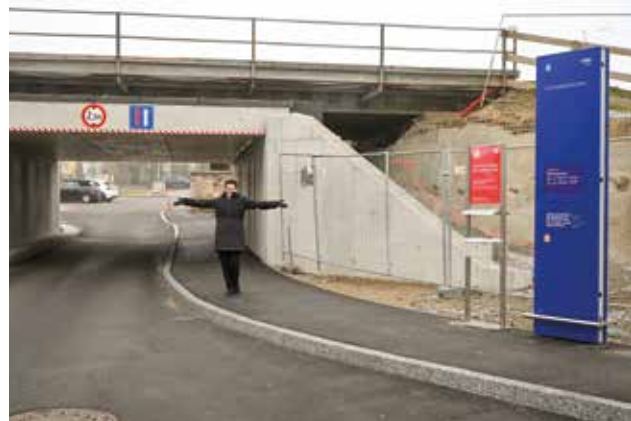
Bürgermeisterin Dagmar Händler freut sich über die neu hergestellte Bahnunterführung
