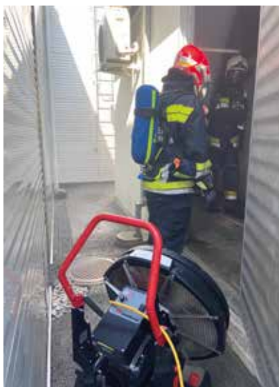
In einer Trafostation war ein Brand ausgebrochen.
