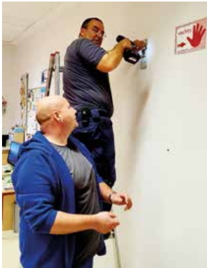
Die neuen Tafeln werden montiert
