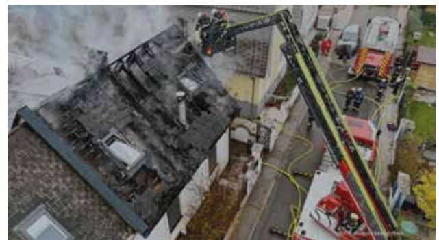
Der Dachstuhl brannte lichterloh
