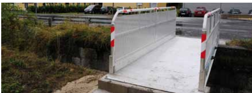
Für mehr Fußgängerkomfort sorgt der neue Übergang über den Wiener Neustädter Kanal in Höhe der Schleuse bei Firma Klinger.
